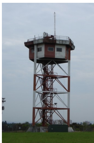
Figura 2.10. Torre de observação.
